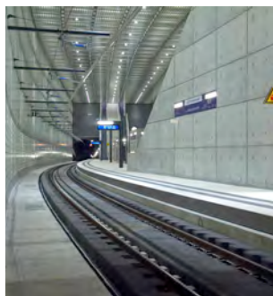
Túnel Leipzig, Alemania
