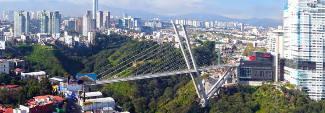
Puente Vidalta, México
